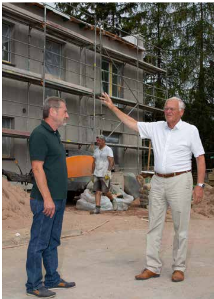
Práce na přestavbě Domovinky pokračují
